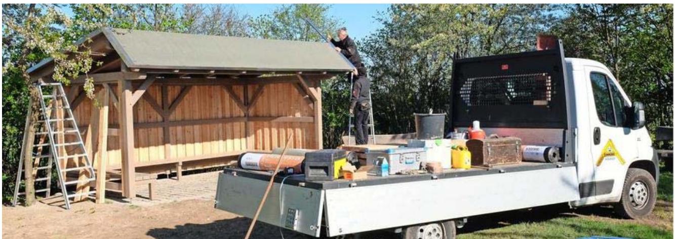
Letzte Arbeiten an der neuen Wetterschutzhütte auf dem Liebschützberg.
